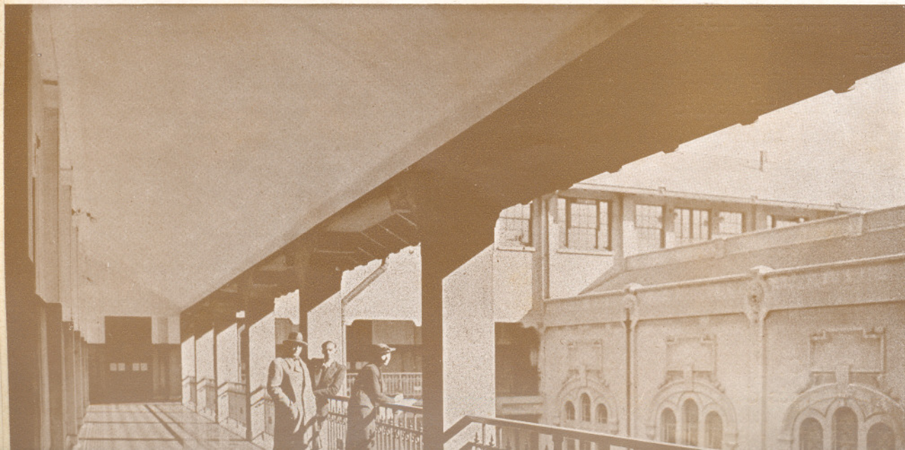
CORREDOR DEL TERCER PISO
