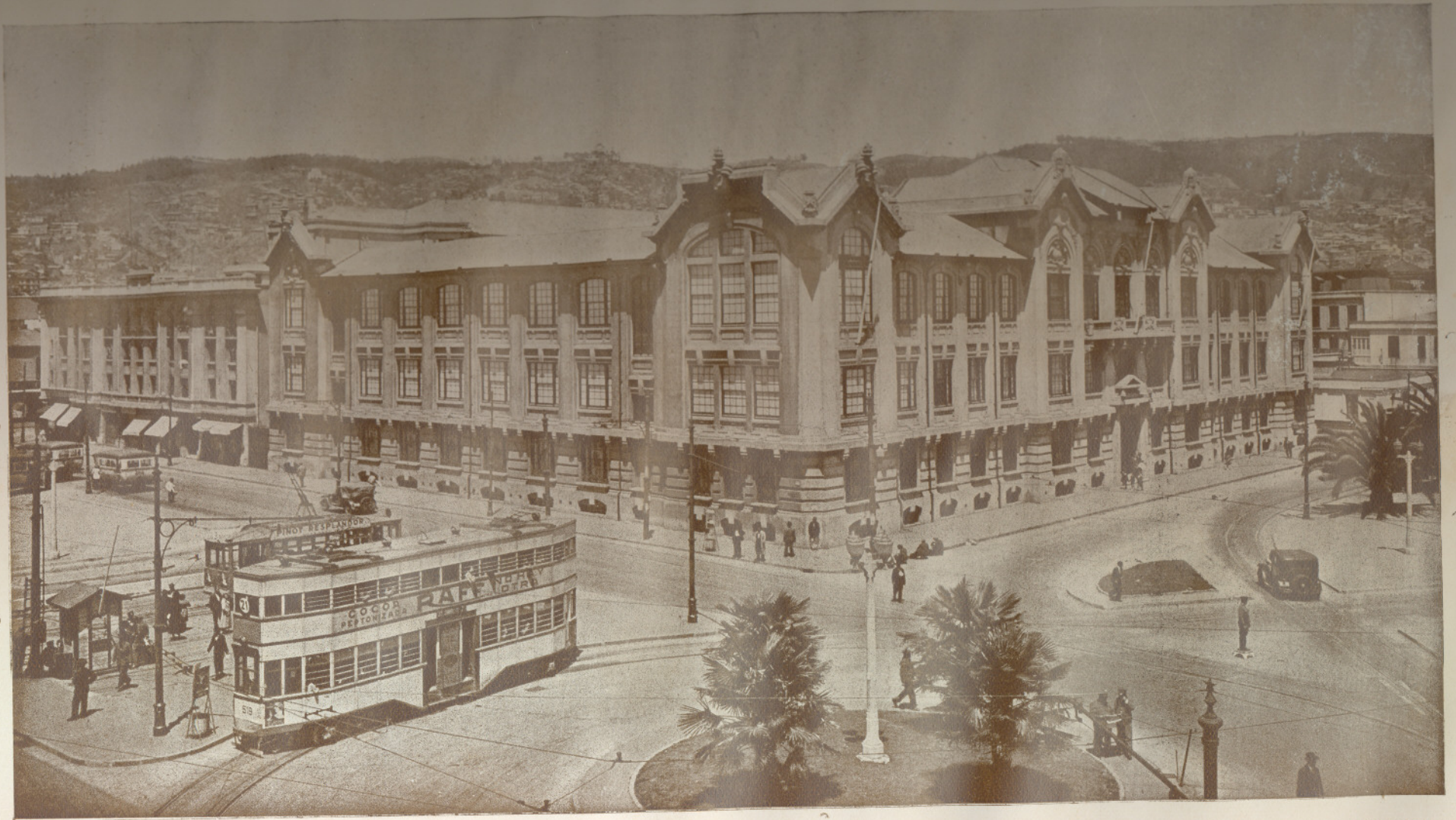
EDIFICIO DE LA UNIVERSIDAD
